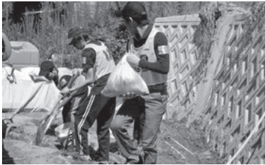
民家の裏に堆積した土砂を取り除く作業。 2018年8月6日(月) 岡山市東区(7名)
