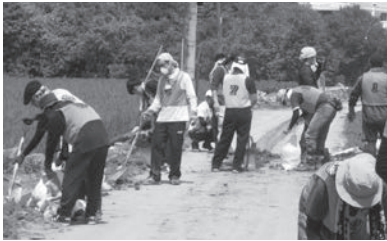
土砂が堆積し轍ができた道路を整備する様子。 2018年7月14日(土) 総社市美袋(21名)
