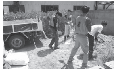
民家に流入した土砂を取り除く作業。 2018年8月27日(月) 倉敷市真備町(23名)
