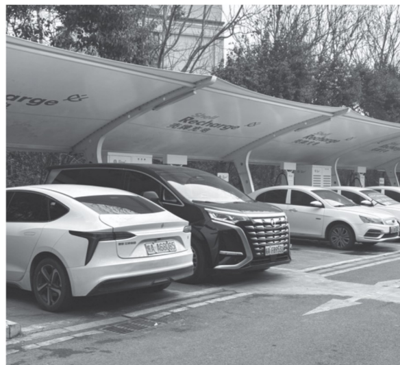
ガソリンスタンドに併設された EV 充電ステーション。トイレや休憩所もあり、充電しながら一休みです。
